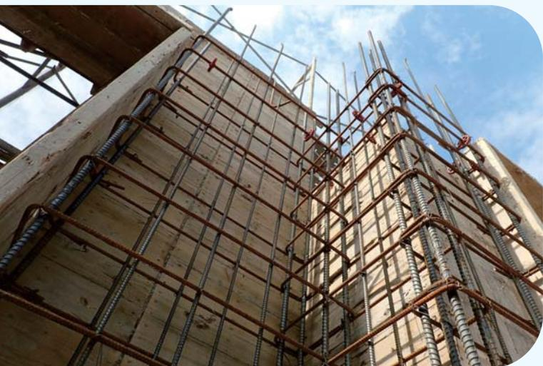
營建業採用系統化工法施工，不僅減少總體碳排放量，更可改善缺工的困境，同時達成最佳的鋼筋施工品質，並有效提升房屋結構整體耐震力。
