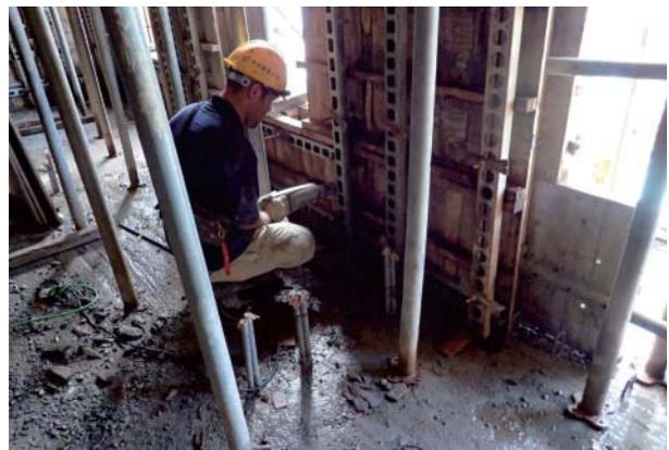
■ 混凝土澆置時，進行外模震動，加強窗邊搗實。
