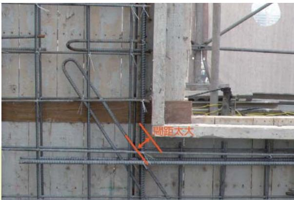
■ 窗角補強斜筋綁紮位置距窗角太遠，造成補強抗裂效果不佳，容易形成斜裂紋。
