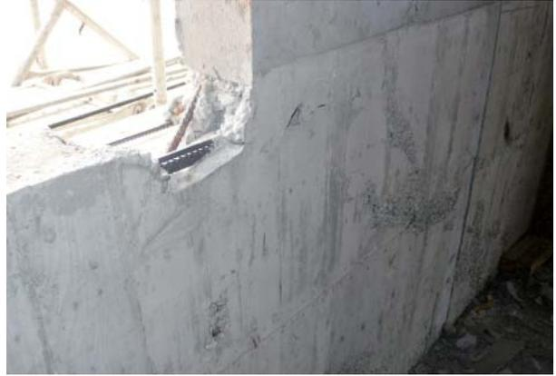
■ 窗角鋼筋較密，混凝土澆置未確實搗實，有蜂窩現象容易造成窗角斜裂縫。
