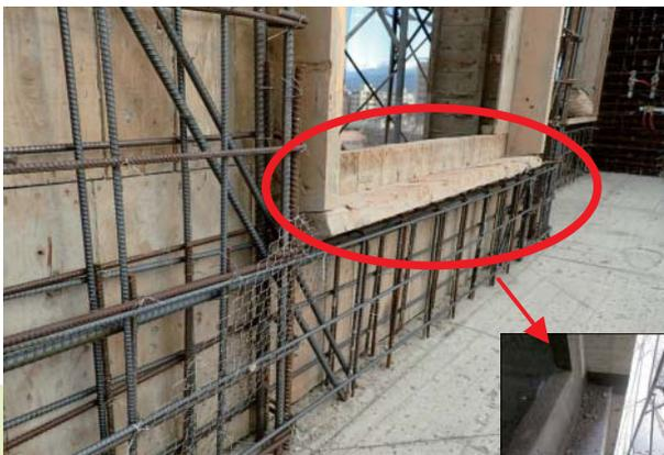
■ 牆開口處之轉角，模板框採倒角及台度頂部框模朝外斜，以能結構洩水。
