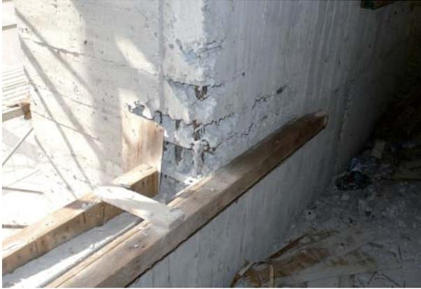
■ 窗框下澆置不良，須二次封模灌注混凝土，產生二次澆置縫而引發滲水。
