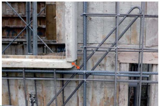
■ 牆開口補強筋，正確的施工，應注意牆開口之補強筋須定位確實綁紮(距框距3-5 cm)。
