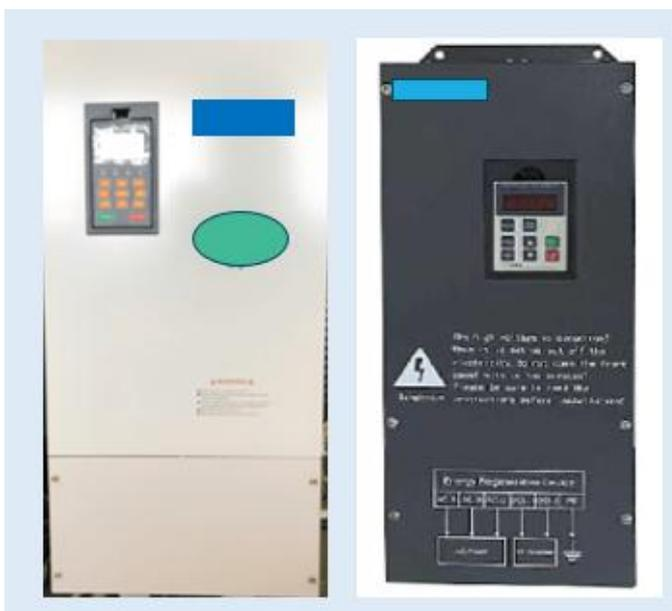
圖 7 電梯的電力回升裝置外觀
