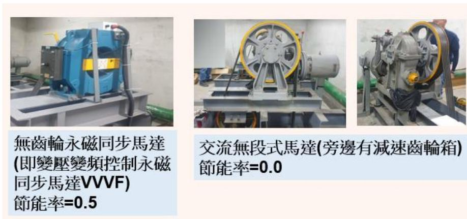
圖 6 無齒輪永磁同步馬達的外觀診斷
